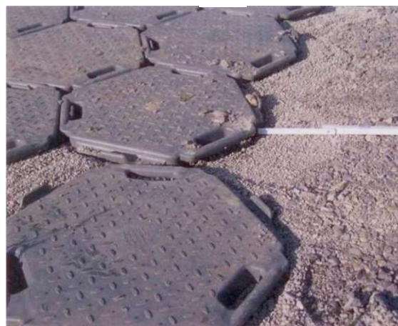
Sechseckwabenbelag: Nach jeder Befahrung mussten die Waben wieder in die Ausgangslage gezogen werden.
