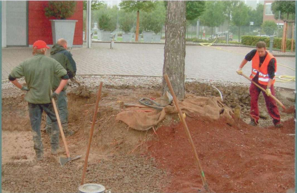
Um eine gute Durchlüftung zu gewährleisten, wurde ein extensives Dachbegrünungssubstrat mit einem hohen Anteil an Ziegelsplitt (10 bis 16 mm) eingebaut.
