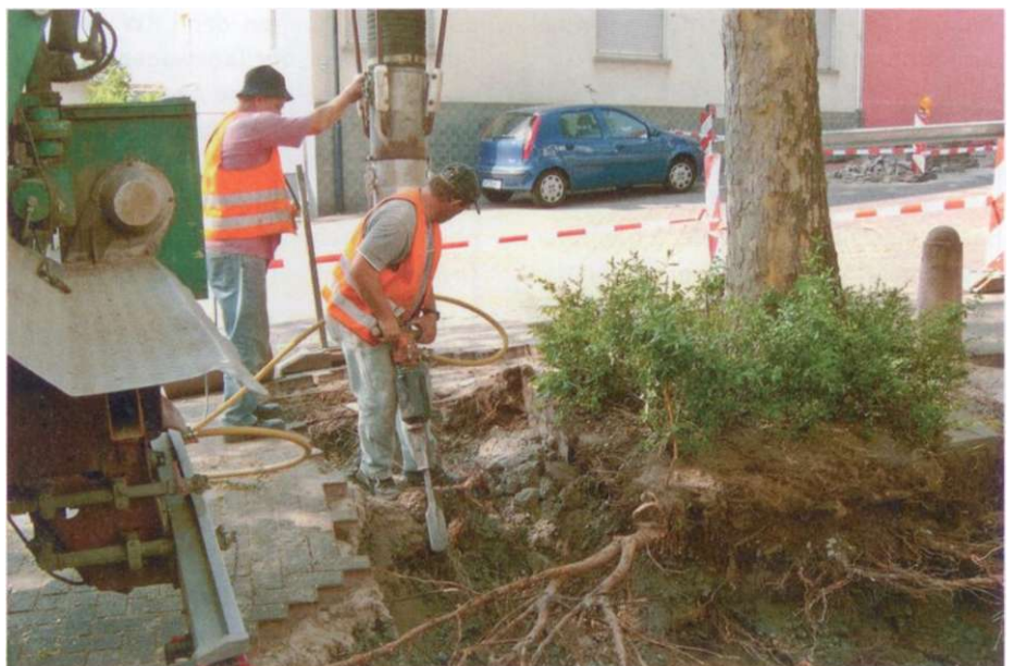
Erfahrung und Feingefühl sind bei Baumsanierungen mit Sauggerät wichtig.
