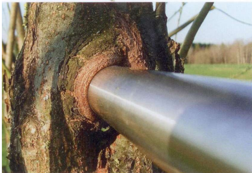
Detailentwicklung einer Überwallung beim Projekt «baubotanischer Steg» aus dem Jahre 2005 (Entwurf: Ferdinand Ludwig und Oliver Storz). Sobald die Metallteile eingewachsen sind, können sie nicht mehr ausgetauscht*werden.
